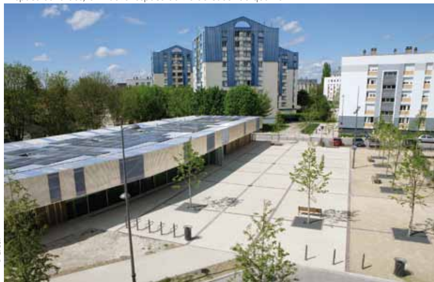
L'Espace Sénardes, un nouvel espace de vie au coeur du quartier
