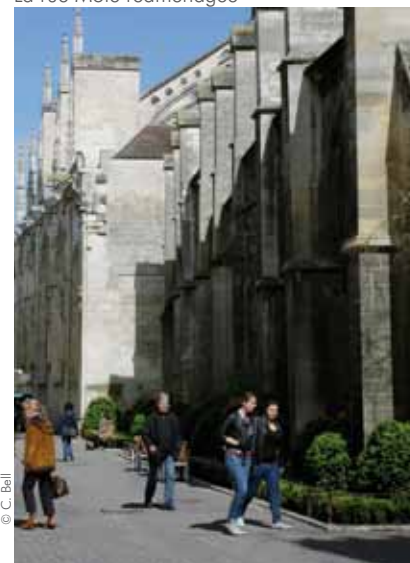
La rue Molé réaménagée
