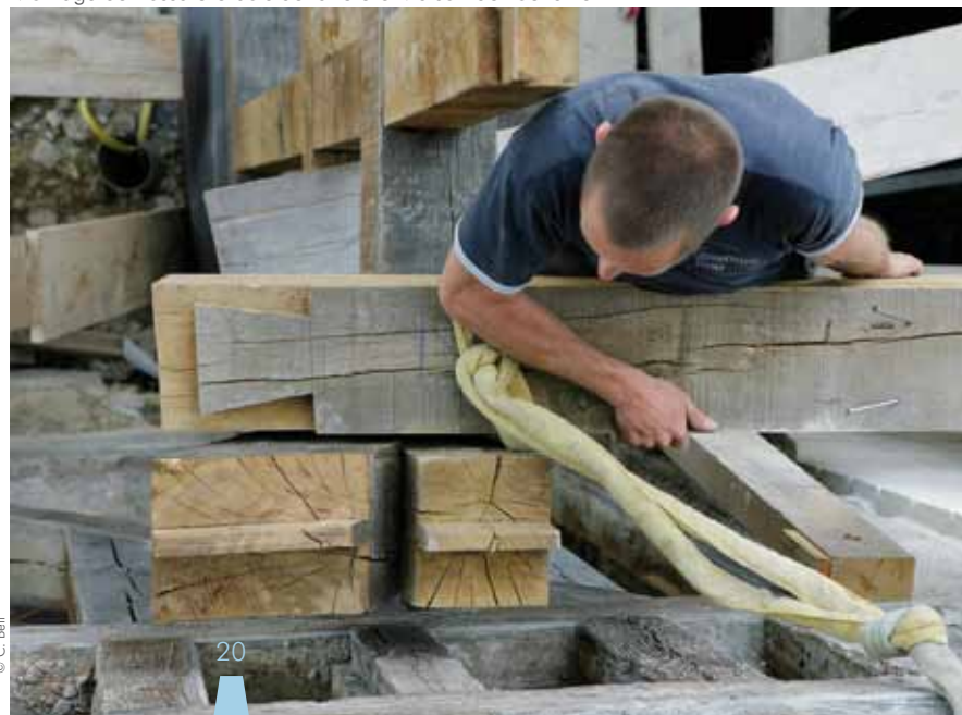
Montage de l'ossature bois de la future Maison du Tourisme
